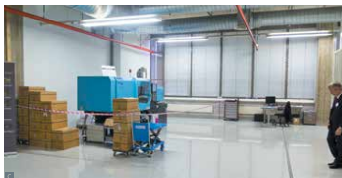
Участок литья под давлением: A — термопласт-автомат IntElect 50–80 компании Sunitomo (SHI) Demag; B - пресс-формы. Сейчас установка одна, но подготовлено место для расширения C
